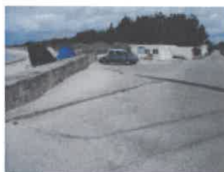
Râtelier, stationnement et local SNSM à proximité de la cale du port de Moustierlin
